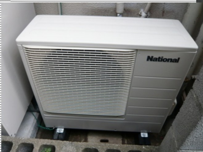
👉 貯湯タンク 👉 ヒートポンプユニット (貯湯タンクの裏側にあります)
