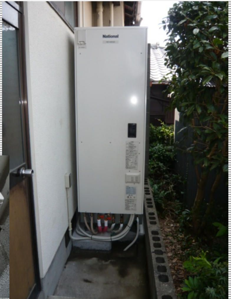
👉 貯湯タンク 👉 ヒートポンプユニット (貯湯タンクの裏側にあります)
